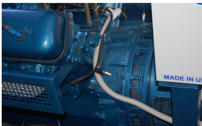
Рисунок 2.6 – Датчик частоти обертання на дизелі
