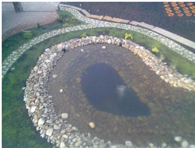
Рис. 4. Заповнення котловану водою і обрізання плівки.
