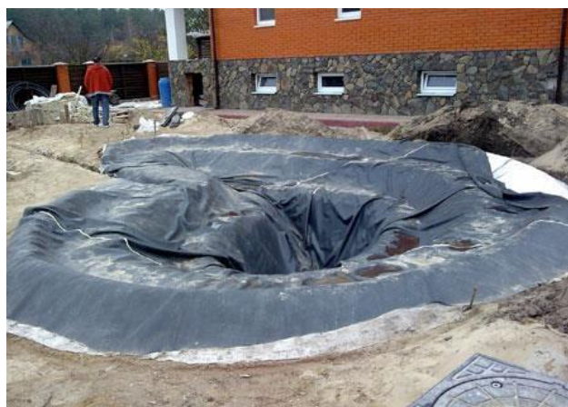
Рис. 3. Укладання плівки
