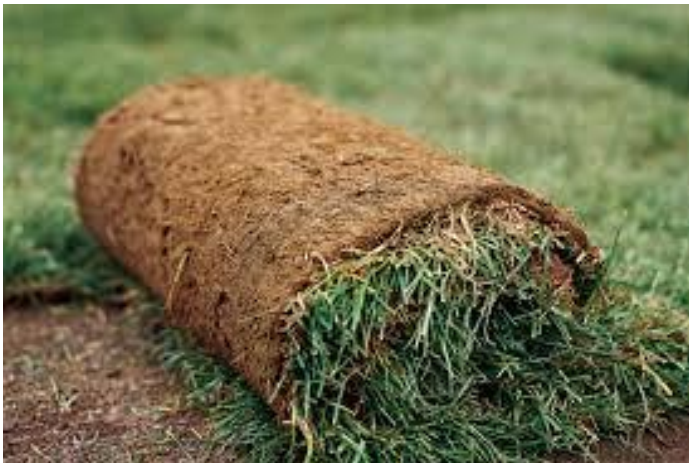
Рис. 39. Зняття газону перед укладанням системи автополиву
