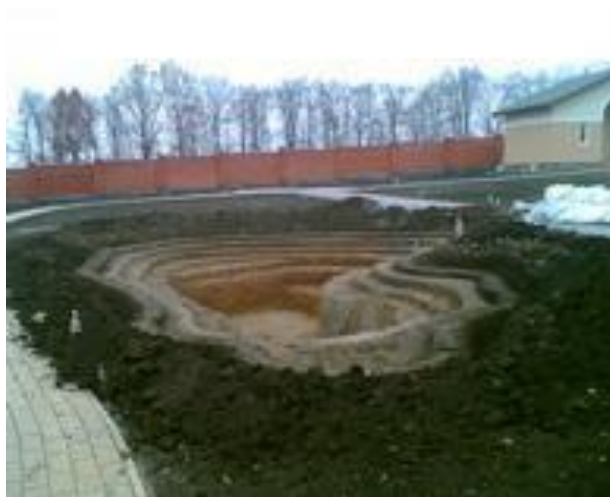
Рис. 2. Формування профілю водойми
