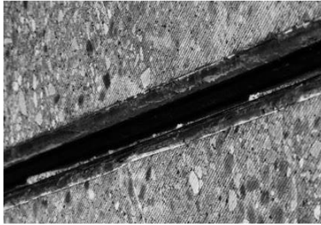
Рис.1.3. Температурний шов бетонного полотна автомобільної дороги, який заповнено асфальтовим наповнювачем ( інтернет-ресурс https://censor.net.ua/r257965 )
