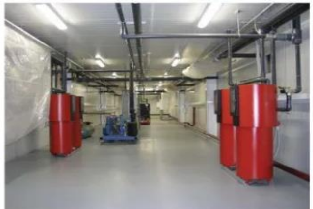
Рис. 1. Транспортний коридор та холодильне устаткування й устаткування РГС в технологічному коридорі сховища-холодильника
