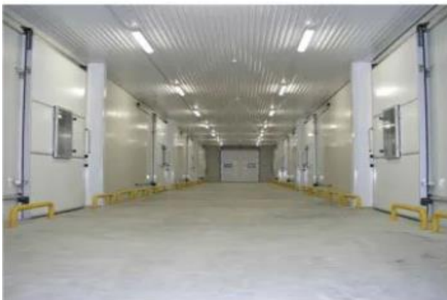
Рис. 1. Транспортний коридор та холодильне устаткування й устаткування РГС в технологічному коридорі сховища-холодильника
