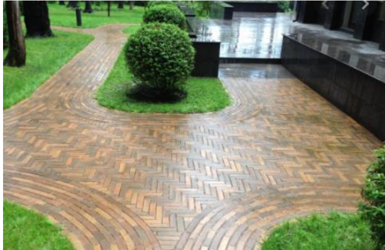
Рис 3.5.3 Варіанти укладення тротуарної плитки
