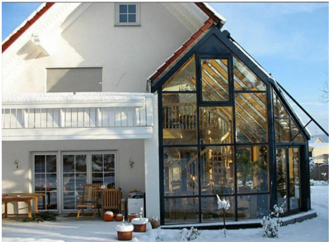
Рис. 3.1. Зовнішній вигляд будівлі зимового саду.
