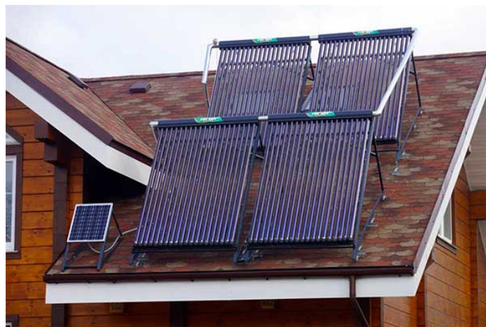
Рис. 2. Трубчастий сонячний колектор
