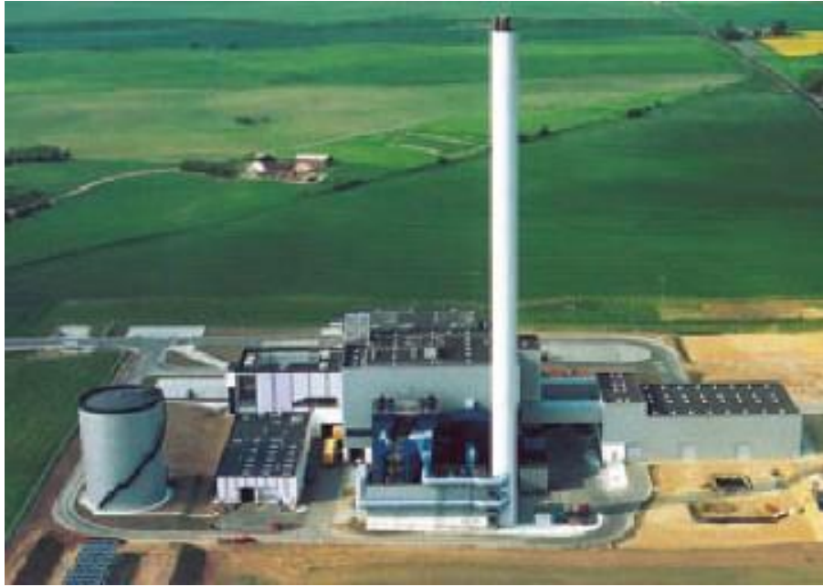
Рис. 1 – Електростанція на біомасі у Данії
