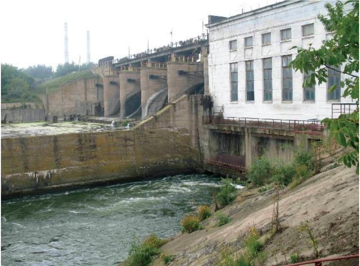
Рис. 1 – Загальний вигляд малої Ладжинської ГЕС потужністю 7,5 МВт на р. Південний Буг в Україні
